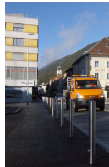
La fin des travaux approche... BLAISE DROZ
